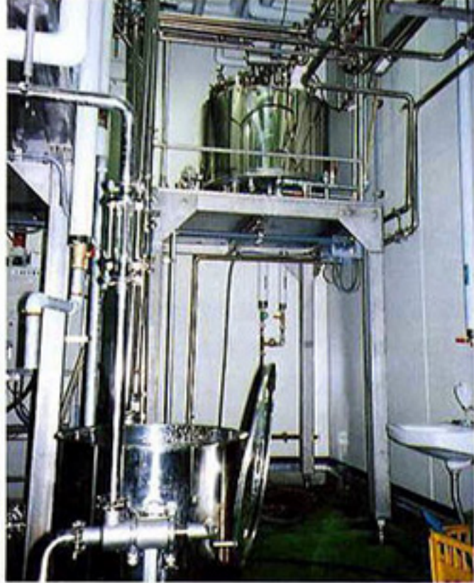
架台上にクッションタンクを設置 手前が受け入れバランスタンク
